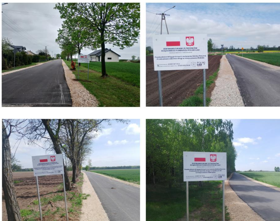
Fot. Wyremontowane drogi gminne (źródło własne)
